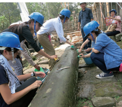
バイヨン寺院にて遺跡修復体験（石の欄干の汚れの除去）
